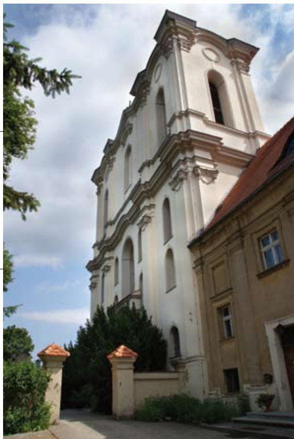
Ryc. 66. Fasada zachodnia kościoła i fragment skrzydła zachodniego klasztoru od strony południowo-zachodniej,
